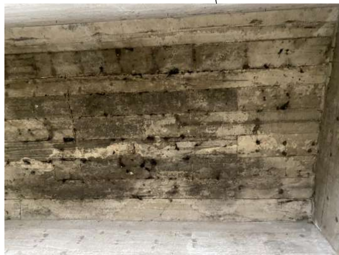
PONTE NOVA, LAJE. PONTOS DE CORROSÃO E POUCO COBRIMENTO NO FUNDO DA LAJE.
