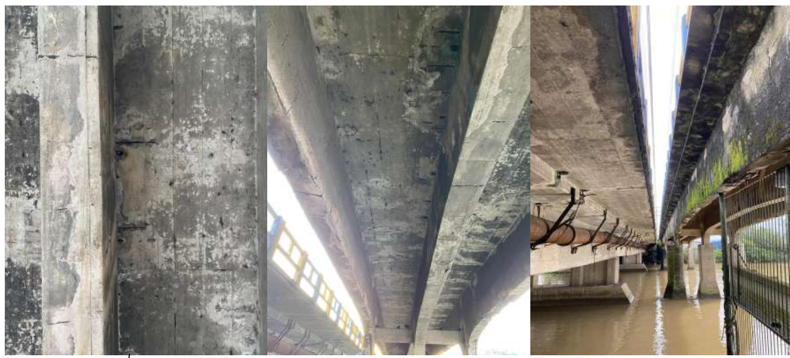
PONTE ANTIGA, LAJE. PONTOS DE CORROSÃO NO FUNDO E NAS ABAS.
