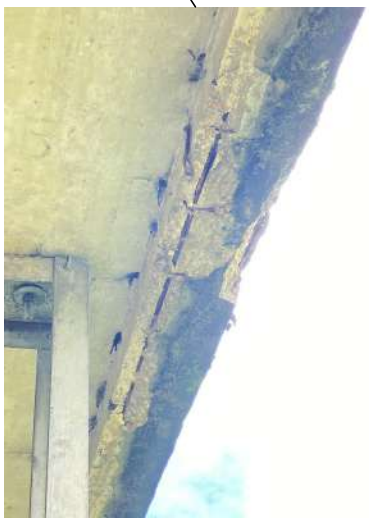
PONTE ALARGAMENTO, LAJE. PONTOS DE CORROSÃO NA ABA.
