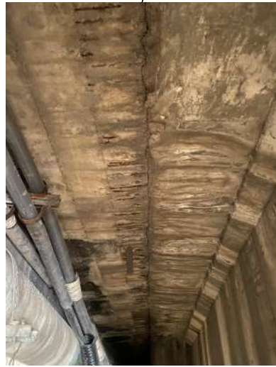
PONTE NOVA / ALARGAMENTO. PONTOS DE CORROSÃO NA JUNTA ENTRE AS PONTES.
