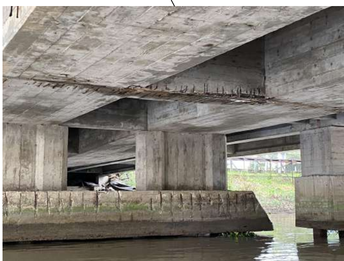
PONTE NOVA, TRAVESSA. ARMADURA TRANSVERSAL CORROÍDA.
