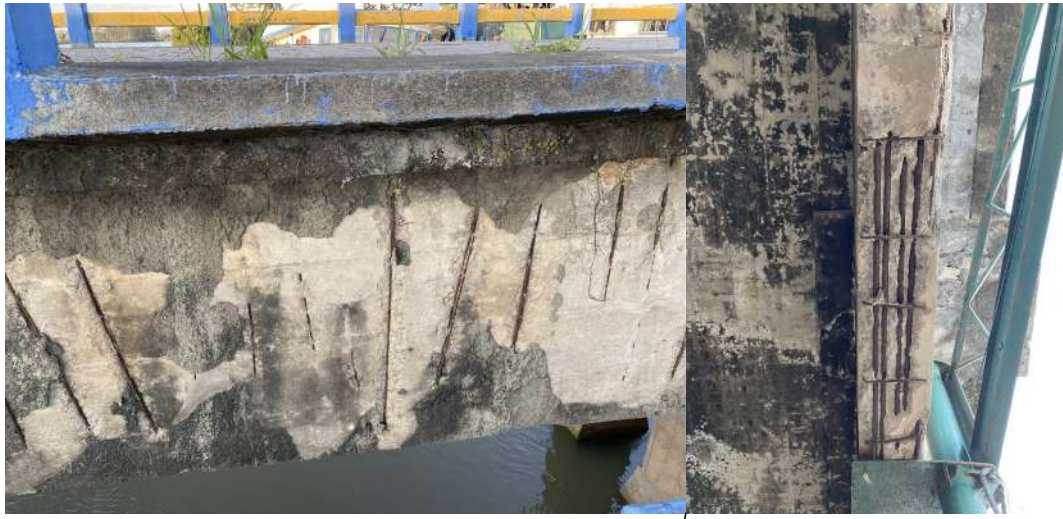
PONTE ANTIGA, LONGARINAS. ARMADURA TRANSVERSAL E LONGITUDINAL CORROÍDAS.
