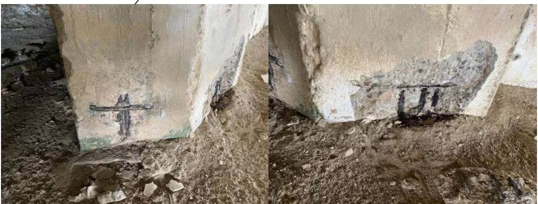
PONTE NOVA, PILARES. ARMADURA CORROÍDA NA BASE.
