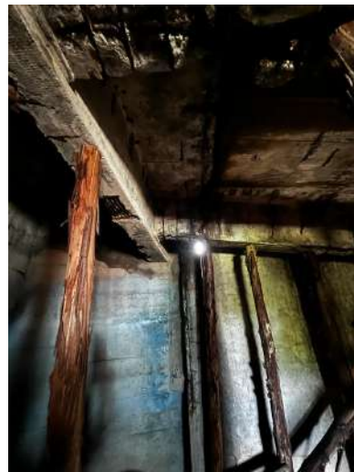
PONTE ANTIGA, RAMPA DE ACESSO. VIGA ROMPIDA E LAJES ESCORADAS
