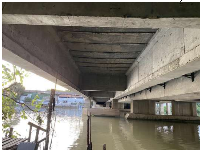
PONTE NOVA AMPLIAÇÃO, LAJE. FORMA DE CONCRETAGEM NÃO REMOVIDA.
