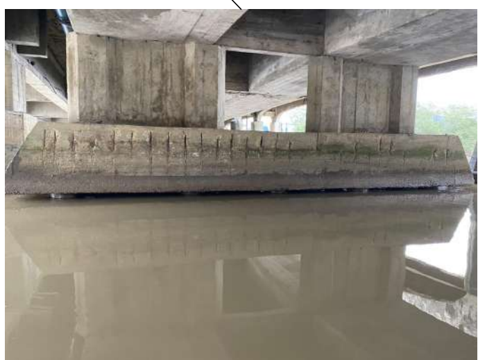
PONTE NOVA, BLOCOS. PONTOS DE CORROSÃO NA ARMADURA.
